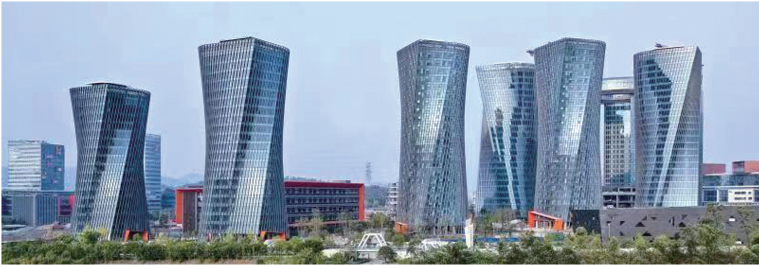
仙桃数据谷“小蛮腰”建筑群
