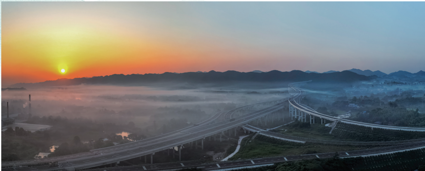
晨曦中的小安溪特大桥
